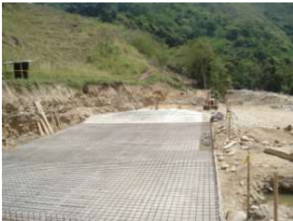
Construcción tanque desarenador
