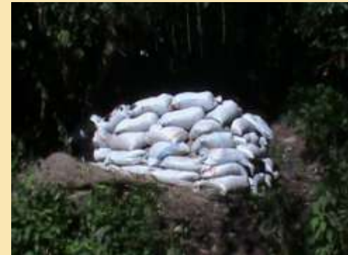
ALMACENAMIENTO MATERIAL DE ARRASTRE
