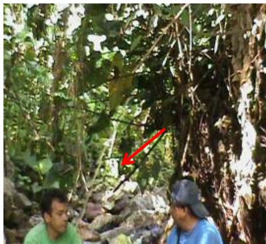
REBOSE DESARENADOR ACUEDUCTO VEREDA CAIMITAL
