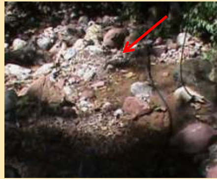
AGUAS ABAJO BOCATOMA INICIAL
