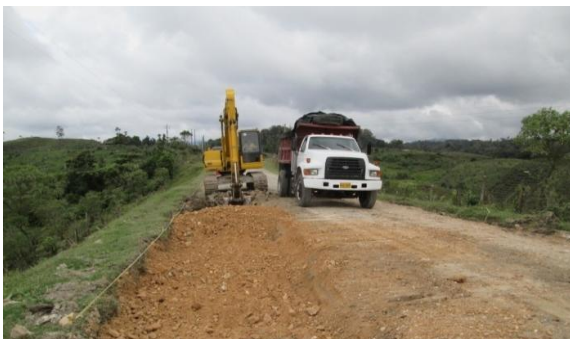
Cajeo para Mejoramiento PR97+800 al PR97+825 c. izq. Cajeo para Mejoramiento PR97+800 al PR97+825 c. der.
