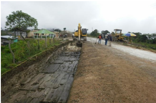
Construcción cuneta PR98+385 costado derecho. Imprimación PR98+485 calzada derecha.
