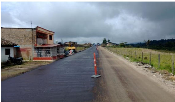
Construcción cuneta PR98+385 costado derecho. Imprimación PR98+485 calzada derecha.
